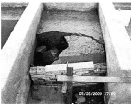
(c) 大规模塌陷——路基破坏
