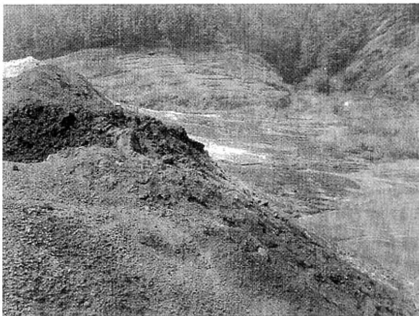
图 5.1 大坝内侧灰渣堆积图
