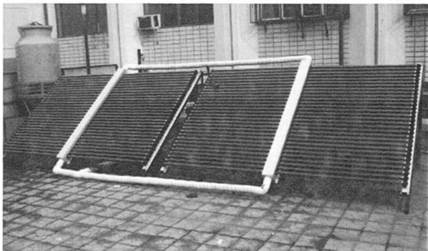
图 3.2 太阳能集热器
