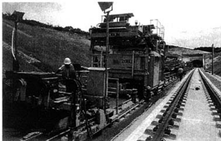
图 1-2 Zublin 轨道结构示意图
