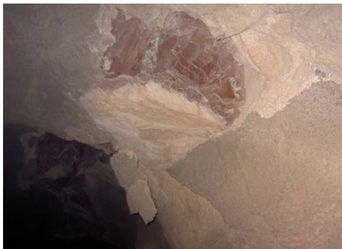
图 2-4 750 m 中段斜坡道顶板冒落情况
