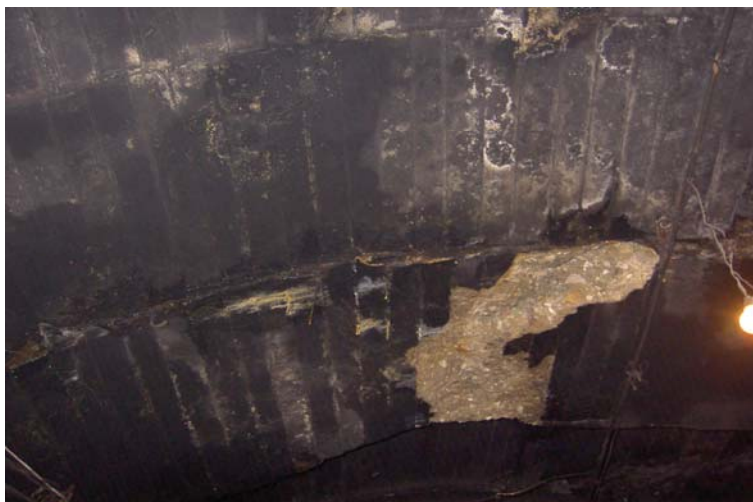
图 2-1 +860 m 主斜坡道变形情况
