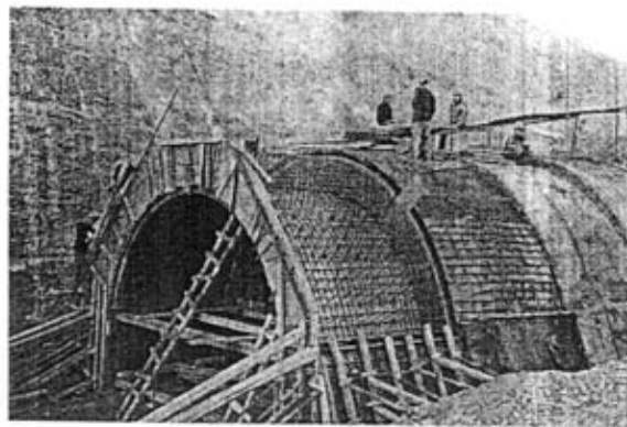
图 7-16 拱涵的施工
