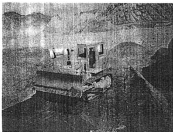
图 7-14 涵顶回填
