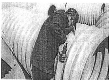
图 2-7 定点后的打磨
