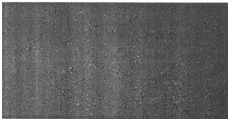
图 3-1 铺装层碾压完成后的鱼尾状裂纹（轻微）
