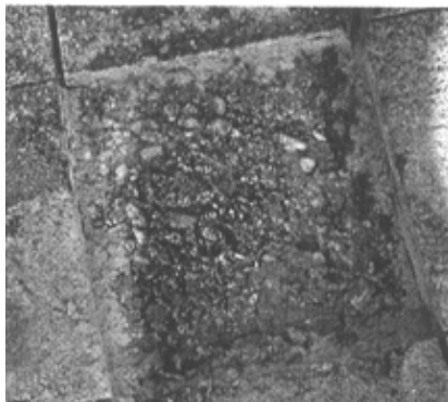
图 5-11 后期鼓包坑洞内部的松散与唧浆
