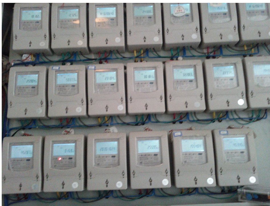
图 6.7 南区 1#宿舍楼第二层所有智能电表
