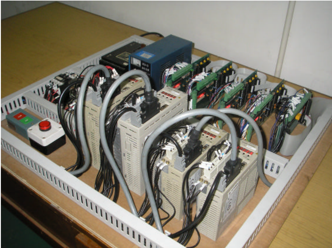
图 3.10 控制柜安装板
