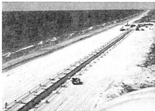
图 2.2A 集束管道平行预制图
