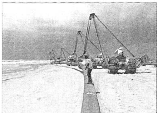
图 2.3B 集束管道平行下水图
