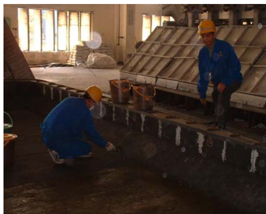
图5-2 预焙铝电解槽涂层涂抹施工
