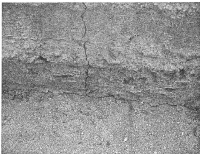
图 6-5 断裂的面板与基层之间有一定脱空
