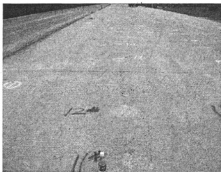
图2-2 基层表面不均匀离析（一般离析）
