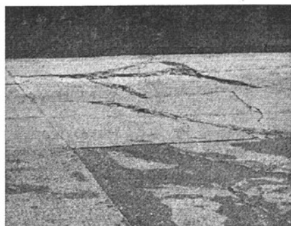
图 6-2 严重破碎面板图(二)
