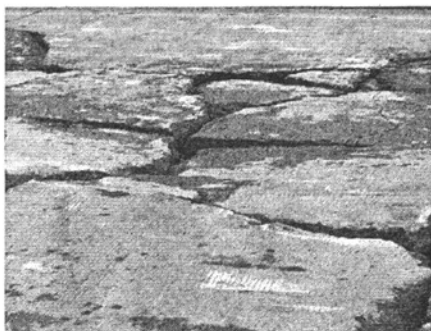
图 6-1 严重破碎面板图(一)
