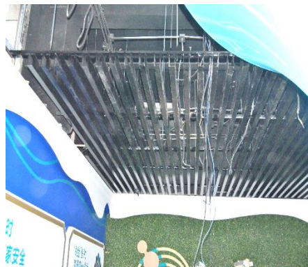
通透式吊顶内部杂乱
