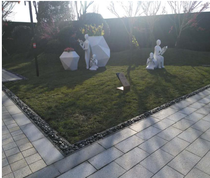
路面两侧排水沟用鹅卵石优化设置
