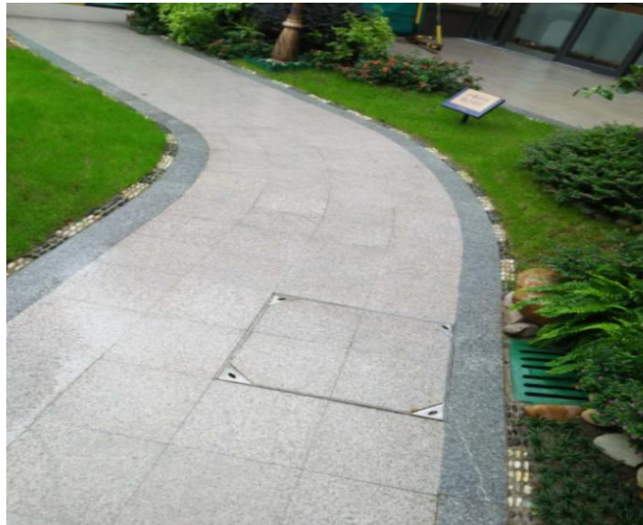
路面两侧排水沟用鹅卵石优化设置
