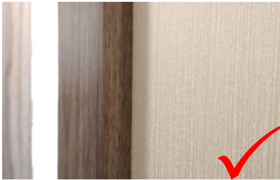
门边先贴墙纸，后安装门套线，自然缝收口
