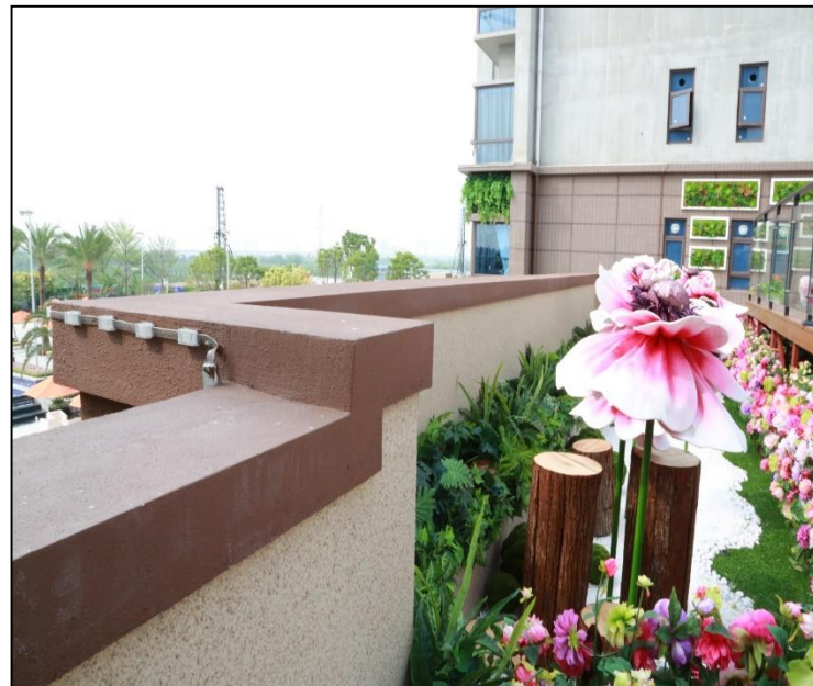
女儿墙压顶线条优化，使具有如滴水线功能
