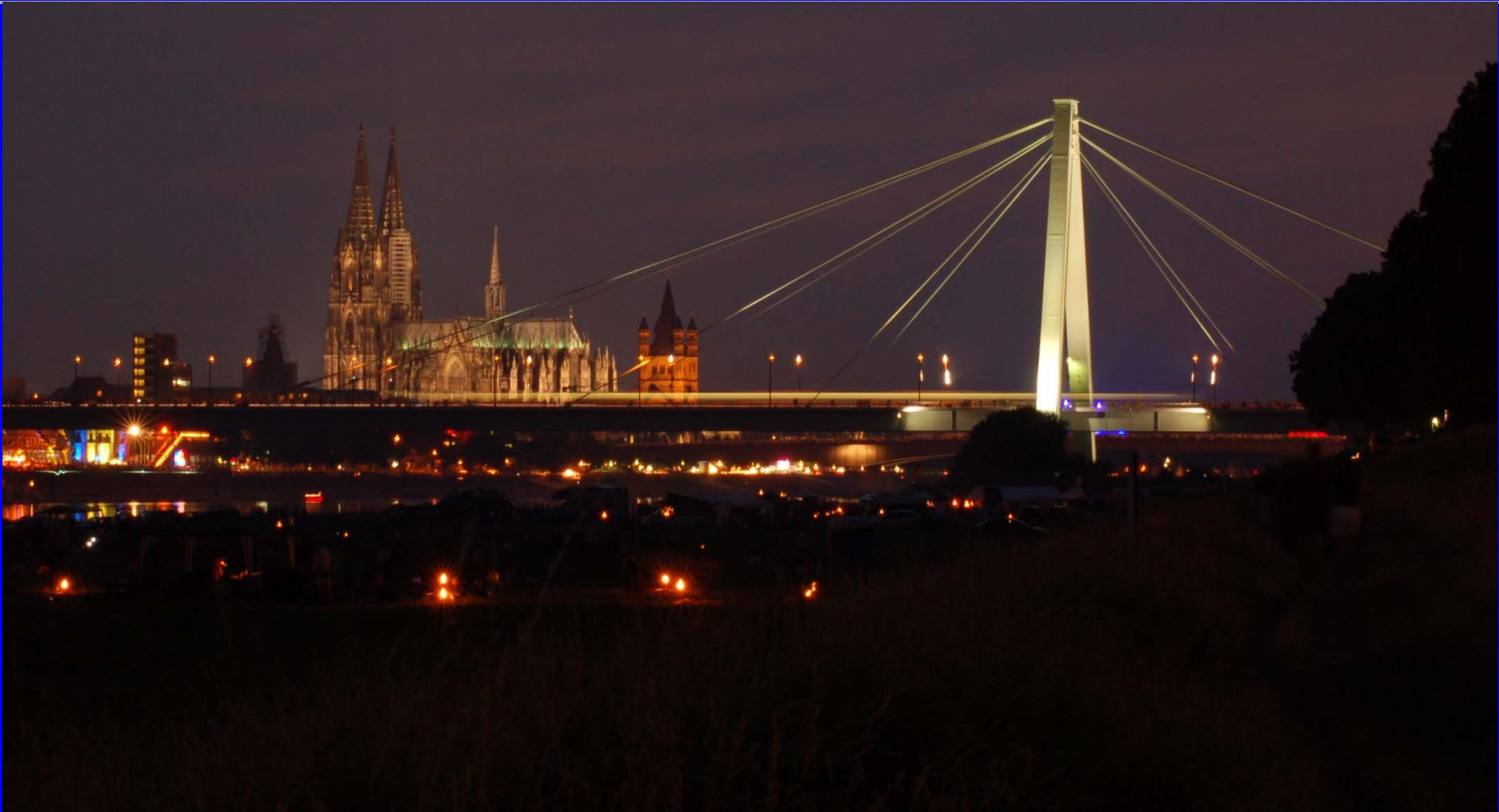
塞弗林桥，1961年，科隆，莱茵河，独塔斜拉桥，主跨302 m，主梁宽度29.5 m。
