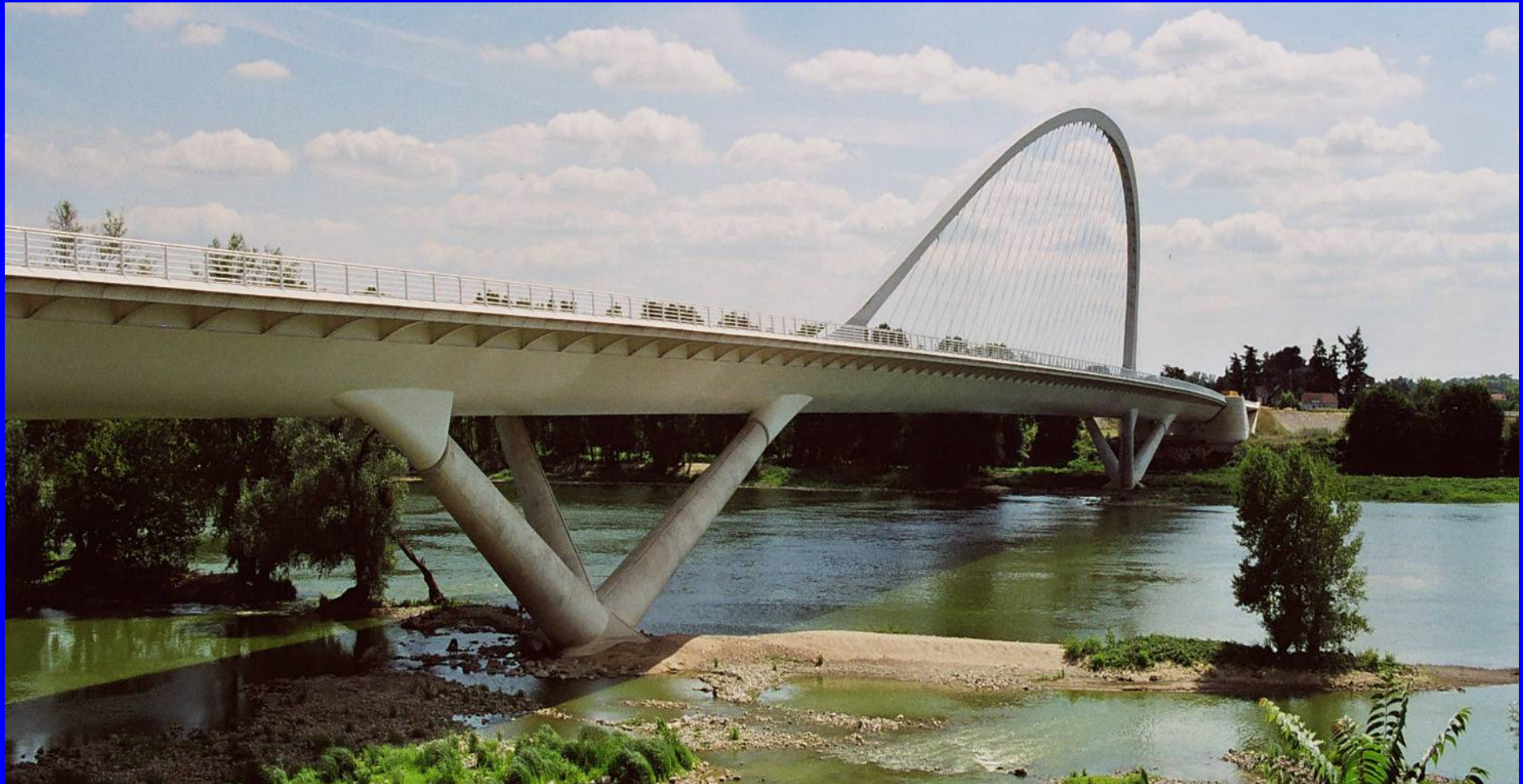
Pont de l'Europe (2000) 主跨201.6米 公路桥 钢拱 钢主梁
