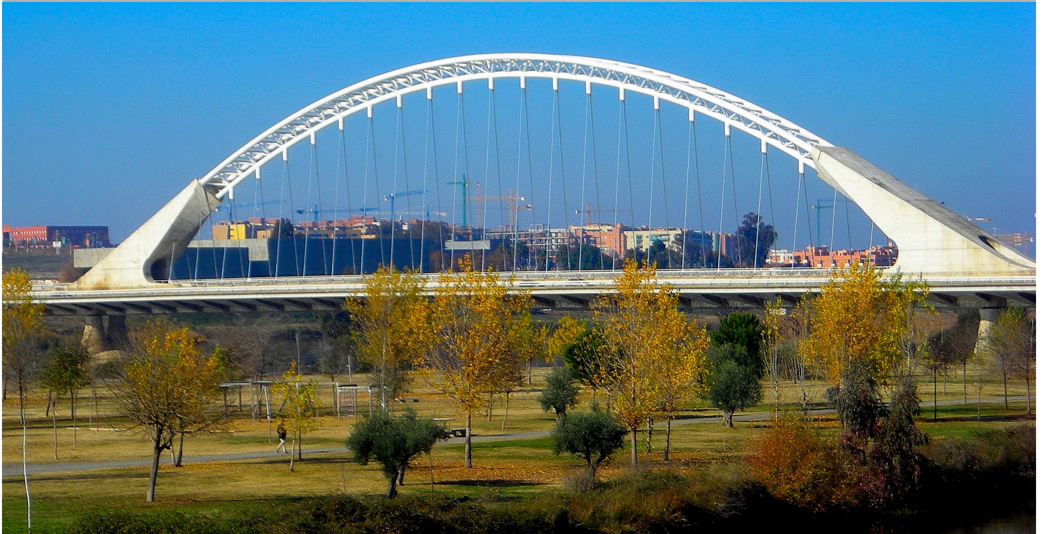
西班牙路西塔尼亚桥, 1991年建成, 是主跨189m的系杆桥。拱高32m
