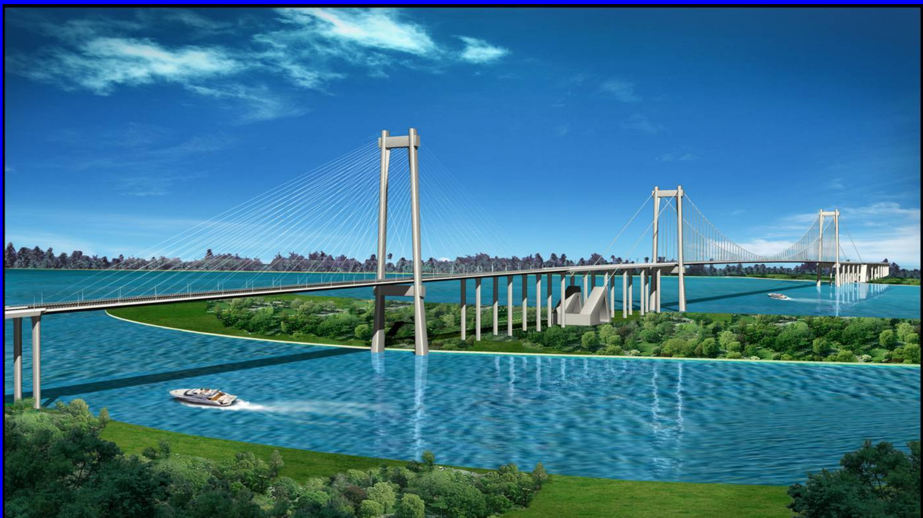
北汊主跨383米独塔钢箱梁斜拉桥 南汊主桥主跨1108米悬索桥
