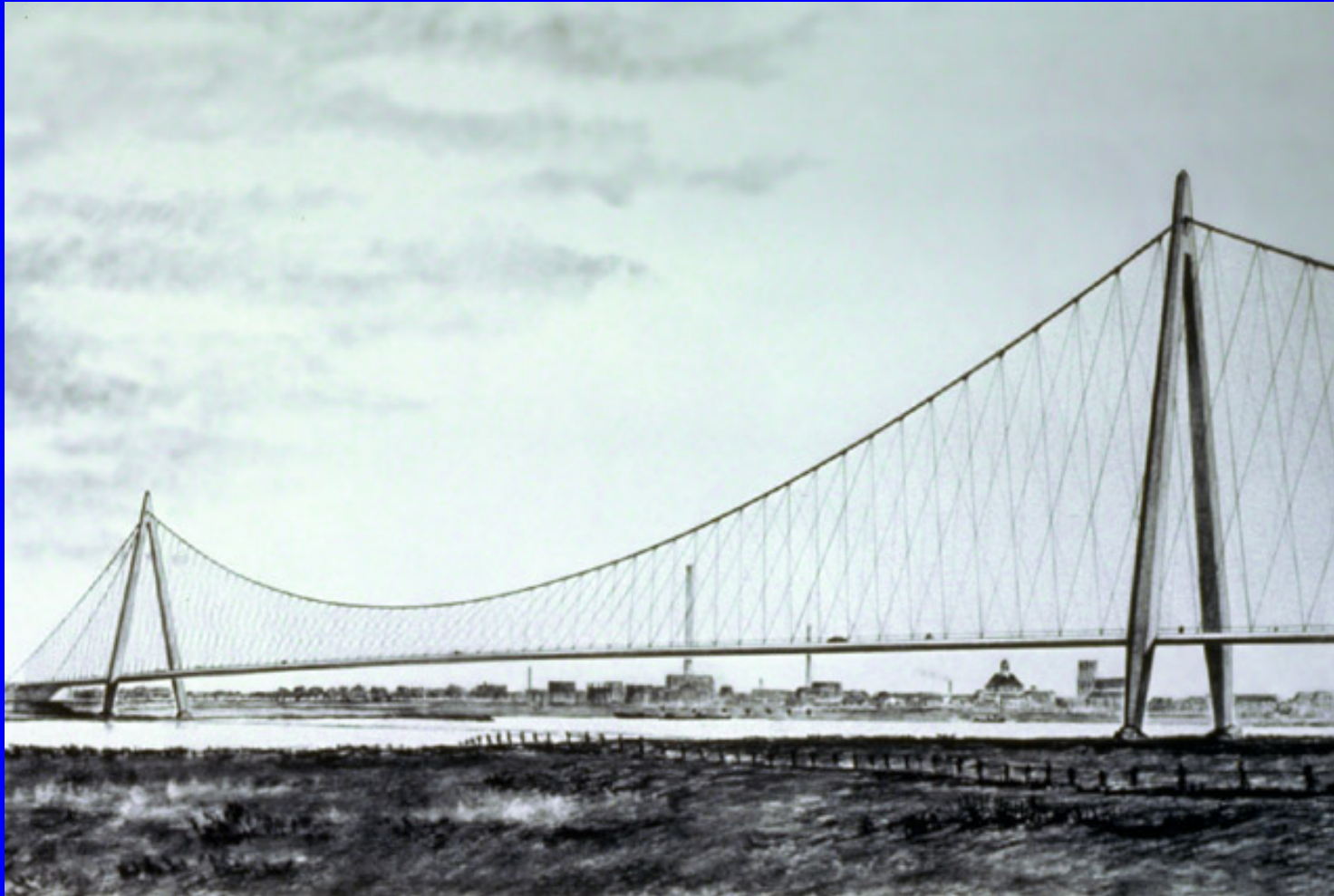
Emmerich 莱茵河桥方案，首次提出将钢箱梁用于悬索桥的加劲梁
