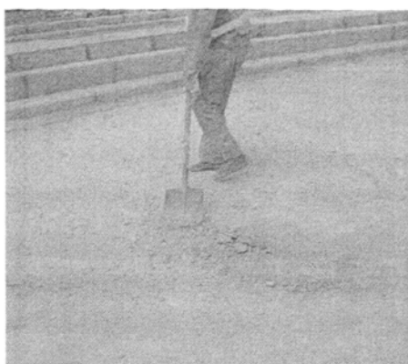
图 5.3 用铁锹铲出路面范围
